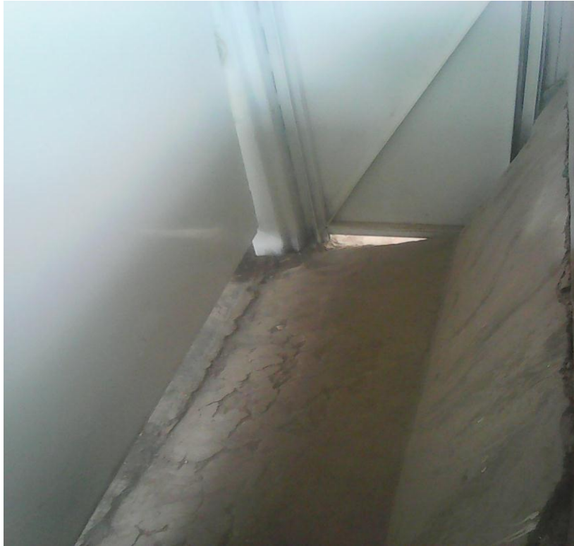
Cajón de aturdimiento de reses
