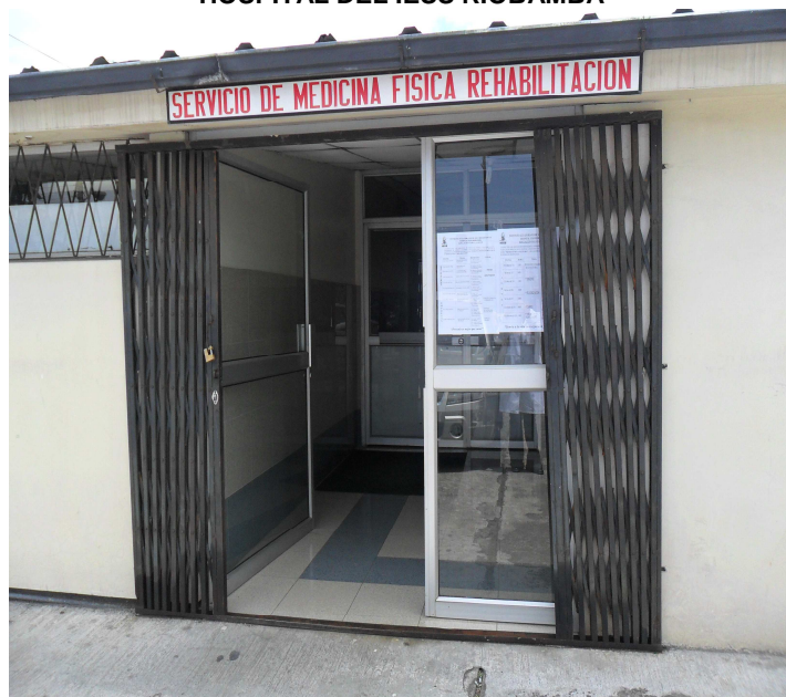
FOTOGRAFIA Nº 20 SERVICIO DE REHABILITACION PARA LOS PACIENTES HOSPITALIZADOS DEL SERVICIO DE TRAUMATOLOGIA.
