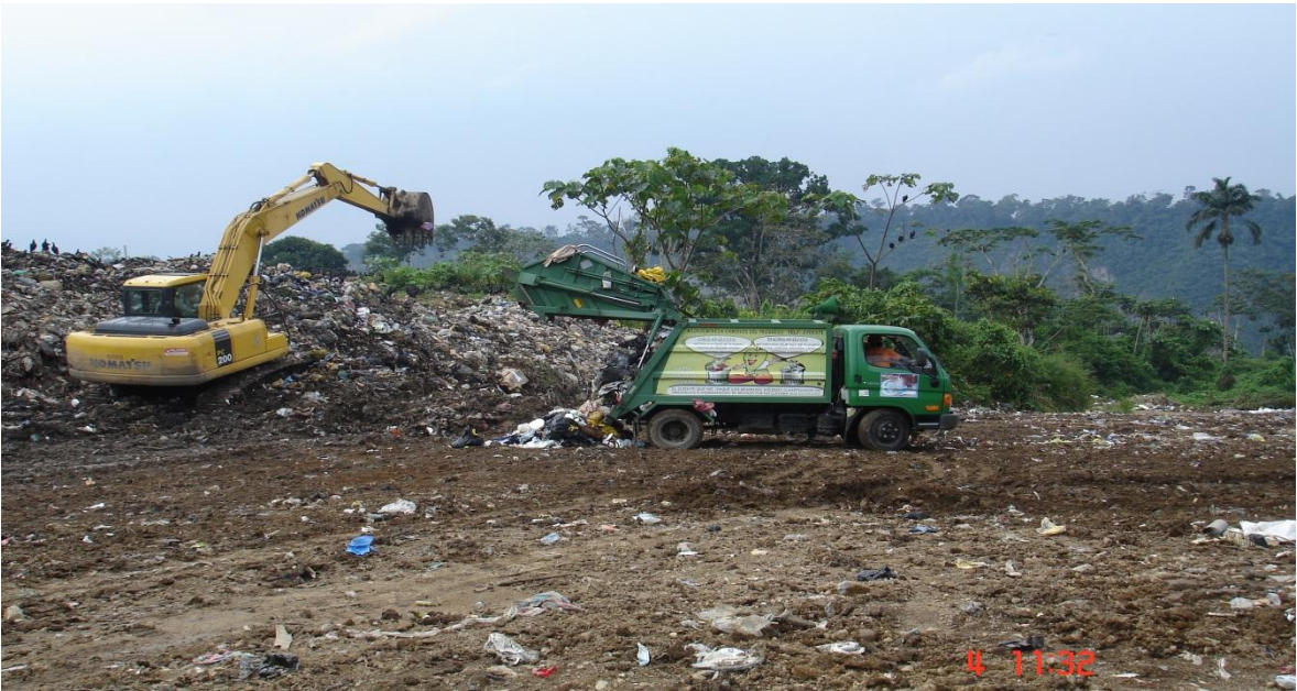
MAQUINARIA MUNICIPAL NIVELANDO EL TRABAJO ACUMULADO DE SEIS MESES POR FALTA DE ADECUADA MAQUINARIA.
