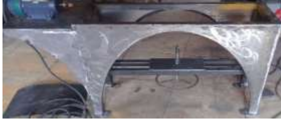
Figura 33-3: Fabricación de las cubiertas del marco rígido
