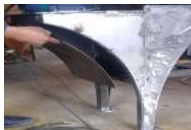
Figura 32-3: Fabricación de las vigas en voladizo y su tapa
