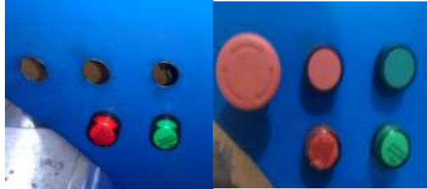
Figura 43-3: Montaje de los dispositivos de mando y señalización
