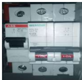
Figura 57-3: Energizar, activar el breaker y disyuntores
