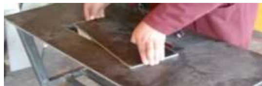
Figura 29-3: Fabricación de la placa de fuerza
