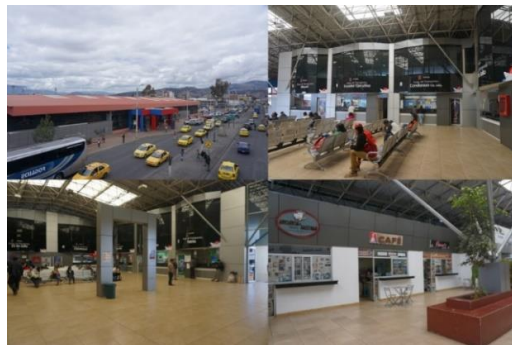
Imagen 2. Vigilancia Terminal Terrestre Interprovincial de Riobamba
