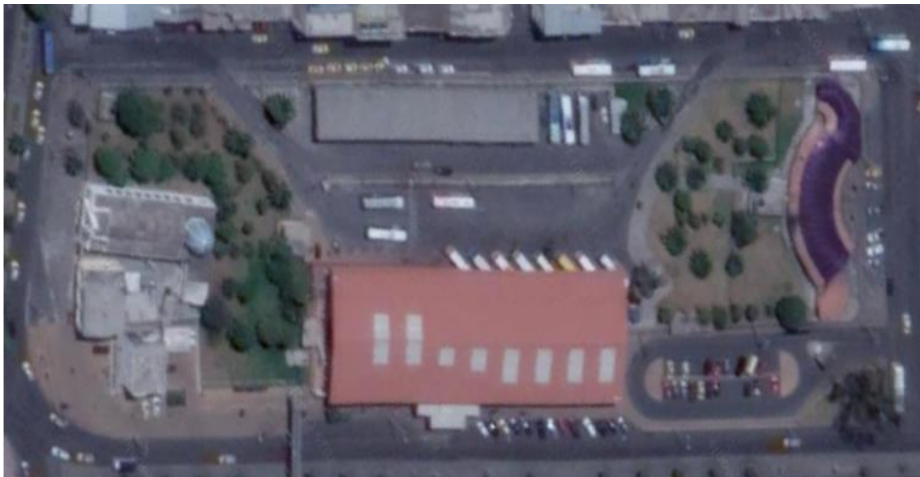
Imagen 3. Terminal Terrestre Interprovincial de Riobamba
