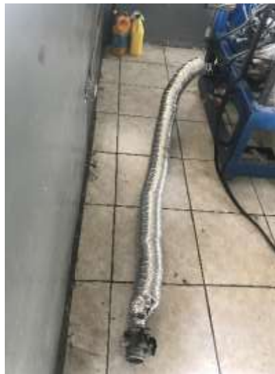
Figura 22-4: Instalación de escape y depurador
