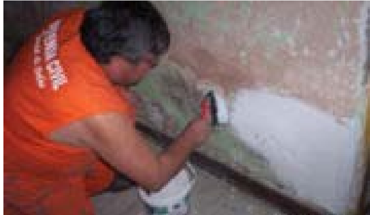
Figura 6 Forma de aplicación de un antisalitre.
