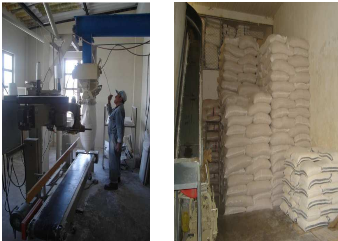
Figura 3.13: Ensacado – cosedora y almacenamiento en bodega
