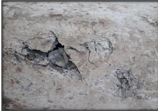
Ilustración 12: Abolladura.
