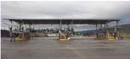
DESPACHO DE COMBUSTIBLES
