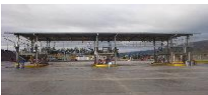
DESPACHO DE COMBUSTIBLES
