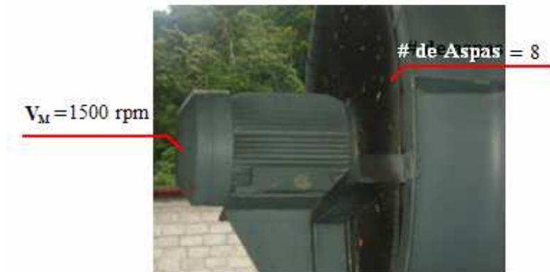
**Figura 5.2:** Ilustración de los datos técnicos del Motor del Ventilador
