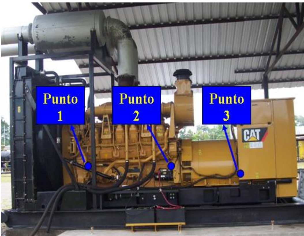
Figura 4.20: Puntos de Medición Grupo Electrónico EGEELE0255
