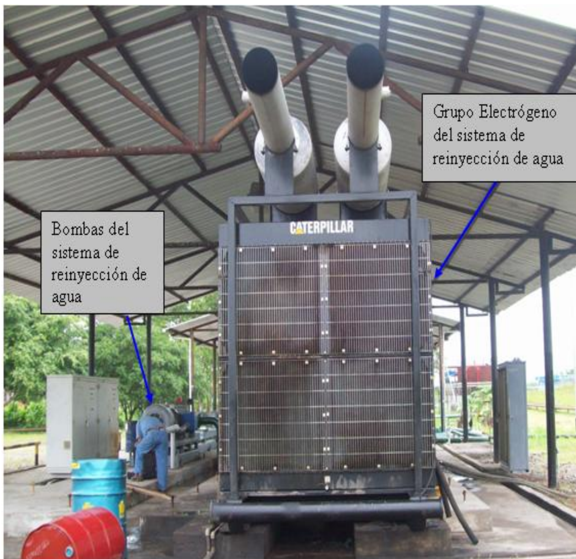
Figura 4.5: Sistema de Reinyección de Agua
