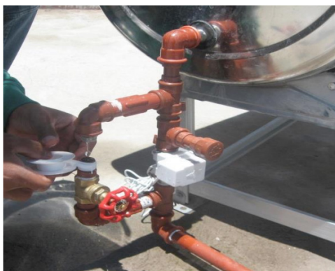
Figura 4. Colocación del sensor de presión.
