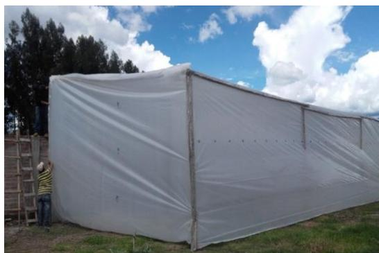
**Figura 3-3:** Instalación del plástico en el invernadero
