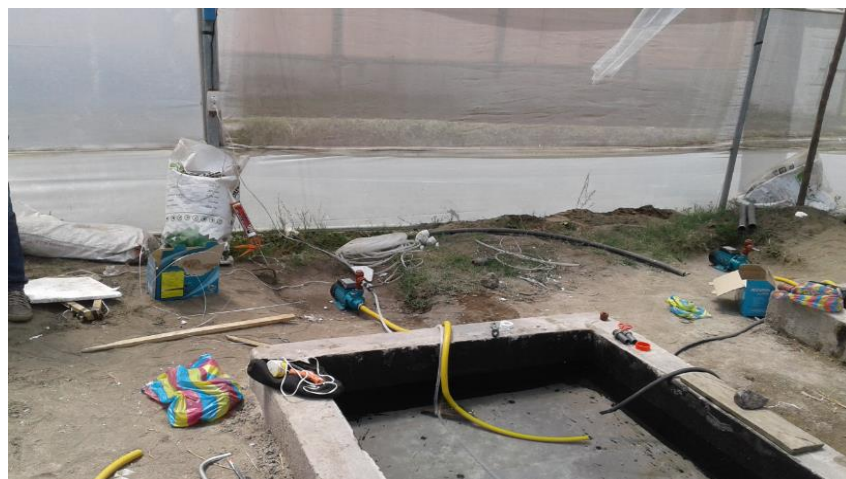
Anexo 13. Instalación del sistema electrónico y las bombas de caudal
