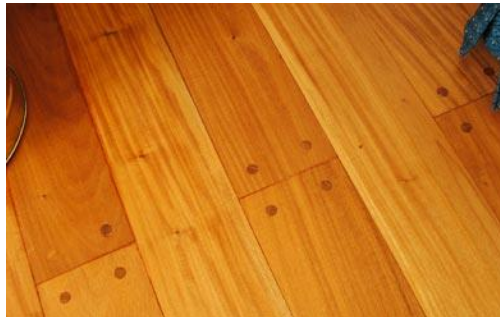
Figura 1. Pisos tarugados
