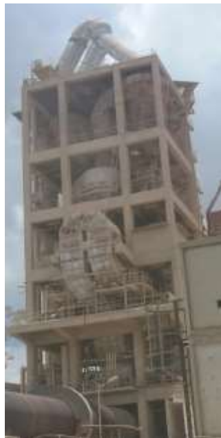
Fotografía 4-2: Torre de Pre-calcinación
