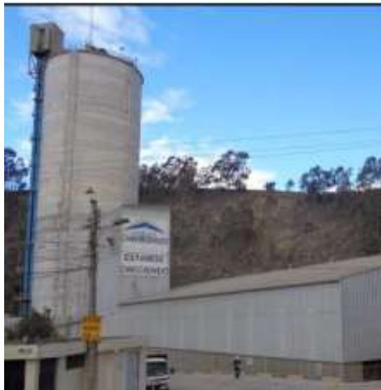
Fotografía 7-2: Silo de cemento
