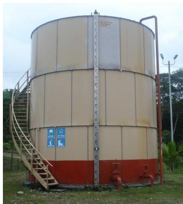
Figura 6: Tanque de suministro de agua del D.C.I. capacidad 1500 bls
