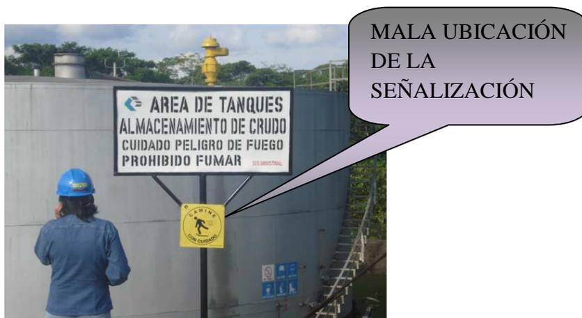
Figura 9: Señalización mal ubicada
