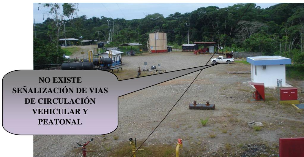
Figura 12: No existe señalización en vías de circulación vehicular y peatonal
