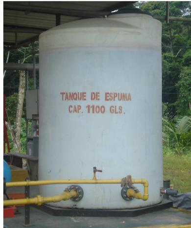
Figura 7: Tanque de suministro de espuma del D.C.I. capacidad 1100gls
