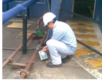
Figura 87. Instalación de manómetro para prueba. Figura 88. Instalación del contador.
