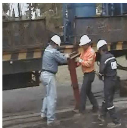
Figura 38. Montaje de soportes fijos.
