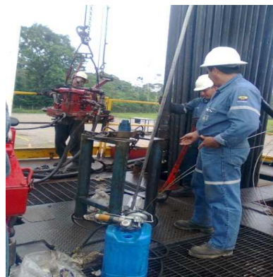
Figura 29. Introducción de la bomba.
