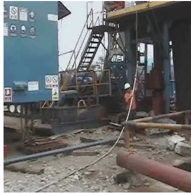
Figura 27. Izada del cable.
