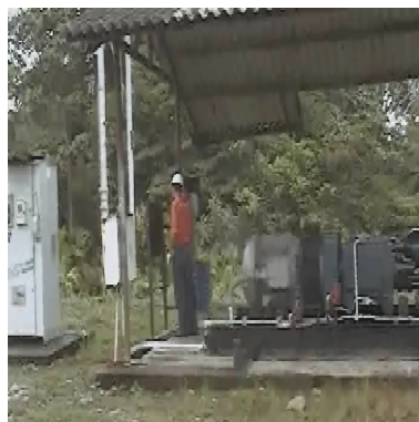
Figura 17. Inspección de tableros.
