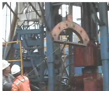
Figura 26. Levantamiento de la polea.
