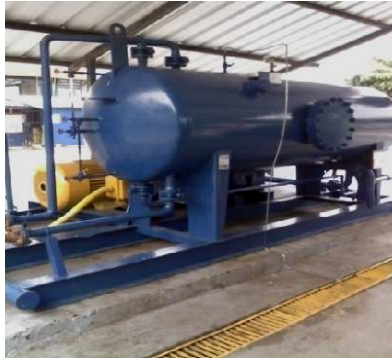
Figura 86. Rejillas de limpieza y evacuación.
