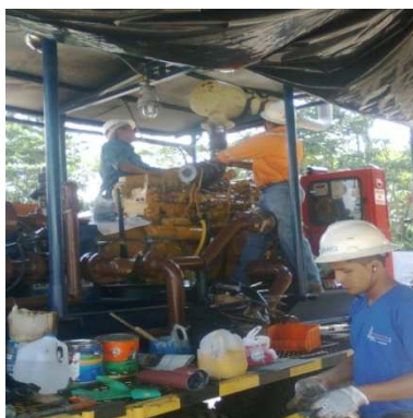
Figura 32. Inspección y mantenimiento de MTU.
