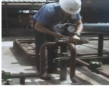
Figura 87. Instalación de manómetro para prueba. Figura 88. Instalación del contador.
