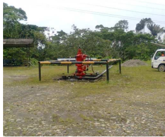
Figura 12. Transporte de la bomba al campo.
