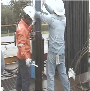
Figura 30. Enzunchado del cable.
