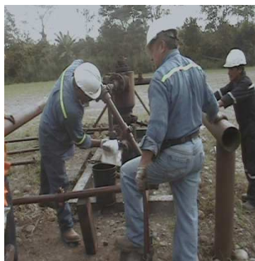
Figura 89. Equipos de protección personal, utilizada en el pozo.
