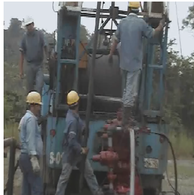
Figura 16. Cambio de bomba reparada.
