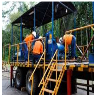
Figura 43. Inspección de presión y cantidad de fluido.
