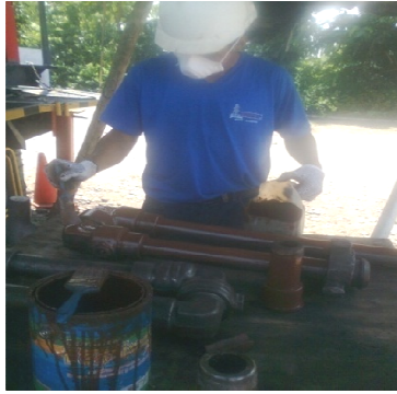
Figura 90. Equipos de protección personal, utilizada en el mantenimiento de tubería.
