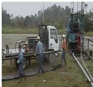
Figura 13. Desmontaje de la bomba.
