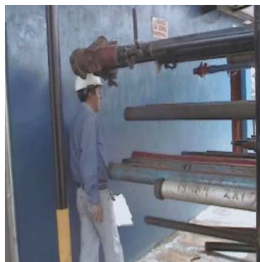
Figura 64. Obstrucción de zona peatonal.
