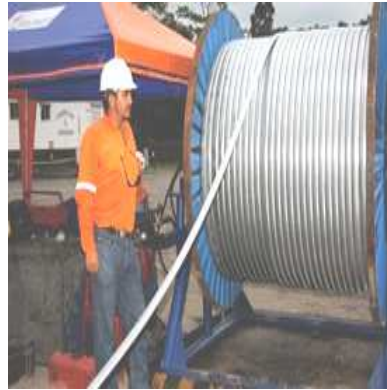
Figura 31. Corrida de cable.
