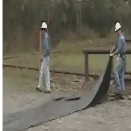
Figura 36. Ubicación de la geomembrana.
