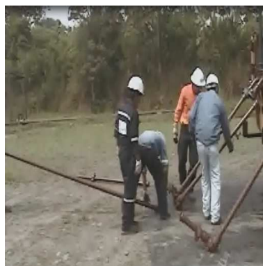
Figura 41. Conexión de tubería de la MTU al Pozo.
