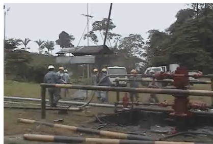
Figura 15. Extracción de la bomba del pozo.
