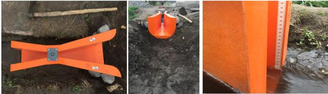
**Gráfico 3-4:** Evaluación del método de riego por gravedad mediante el aforador parshall.
